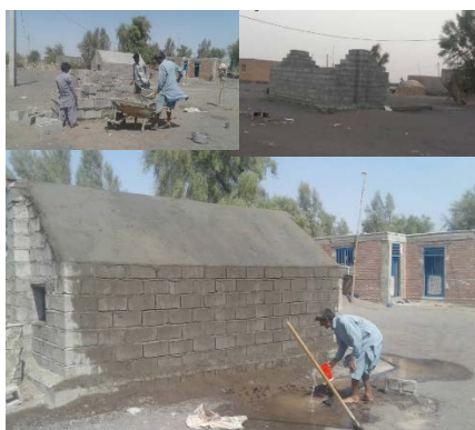
اجراس سقف کنتوک و ساخت سرویس
