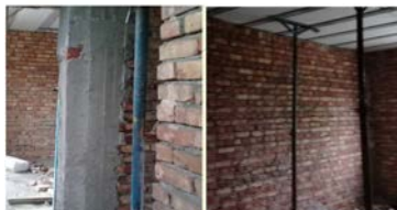
تکمیل سقف خانه دز
